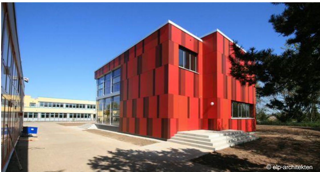
Abb. 7: Holzbausysteme punkten beim Erweiterungsbau mit kurzen Bauzeiten.
