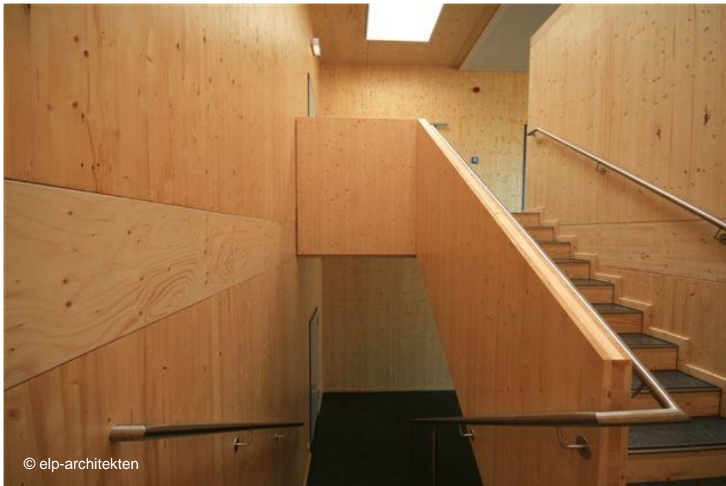
Abb.2: Durch ein Sonderbrandschutzkonzept konnte das Treppenhaus in Sichtqualität ausgeführt werden.
