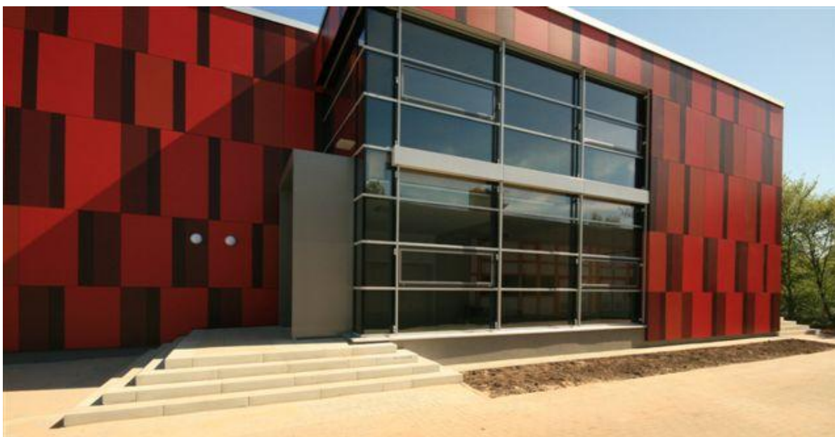
Abb. 1: großformatige Fassadentafeln gliedern den Erweiterungsbau
