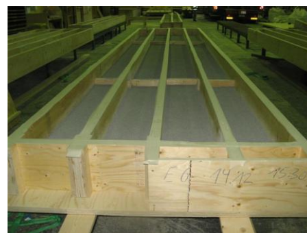
Abb. 4: werkseits eingebrachte Kalksplitt-Schüttung
